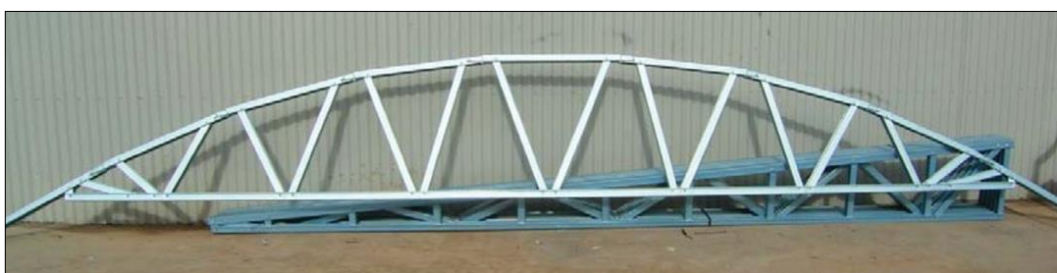
Ferme de forme arrondie
