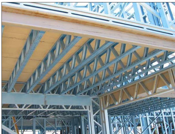
Solives de plancher
