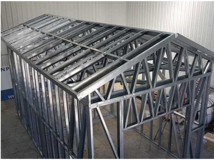
Avec la Bati-FabLab, un robot fabrique l'ossature métallique de votre maison. Elle correspond exactement aux configurations que vous avez choisies. [www.bati-fablab.com](http://www.bati-fablab.com)
