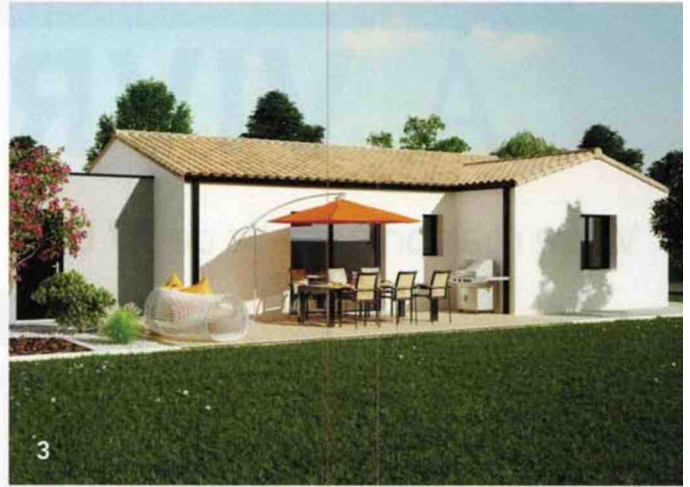
Maisons Prim Access
